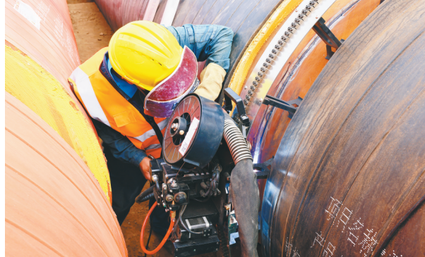
“东城智慧”管网项目持续推进,“自动焊”提升工作效率,为今冬供热再添“新动能”。
