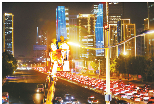
点一盏明灯,照万家灯火。工作人员加强巡检,全力保障国庆假期城市照明。
